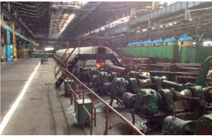
De staalfabriek in Dnepropetrovsk
